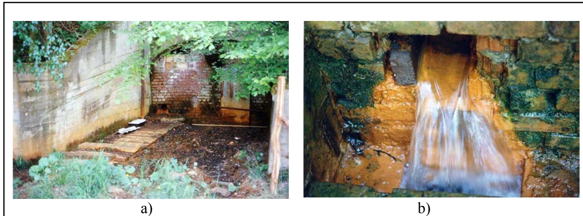
Abb. 21: a) Stollenmundloch im Hagental b) MP 1, Grubenwasser strömt durch den Grundablaß aus dem Stollen
