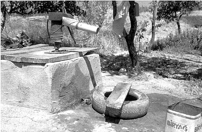
Abb. 7 Für Trinkwasser genutzter Schachtbrunnen BSC am südlichen Ortsrand von Çıplak.
