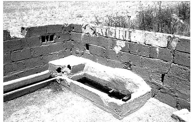
Abb. 16 Als Viehtränke genutzte, gefasste Quelle QPT nahe Paşa Tepe. Die Quelle befindet sich am rechten Bildrand unter Steinen im Gestrüpp.
