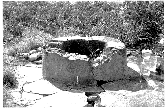
Abb. 4 Ungenutzter, gemauerter Schachtbrunnen BCR in einem Baumwollfeld.
