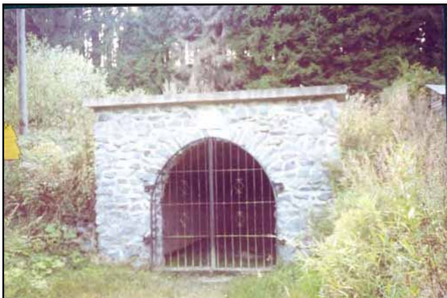
Abb.80: Das Mundloch des Neuen Glasebachstollens
