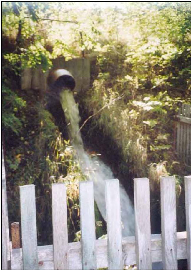
Abb.84: Entwässerung der ehemaligen Grube Einheit in Elbingerode
