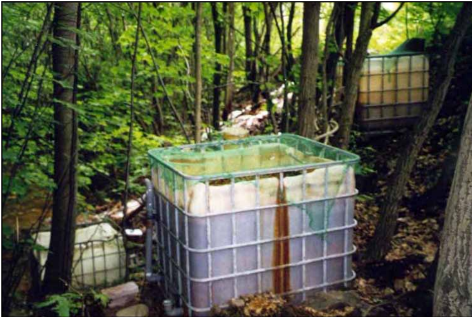
Abb.61: Pilotanlage zur passiven Grubenwasserreinigung am Hagentalstollen
