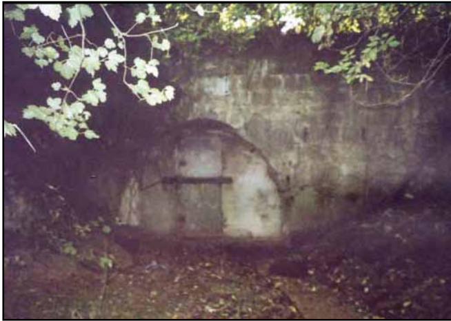
Abb.86: Mundloch des Walter-Hartmann-Stollens in Blankenburg
