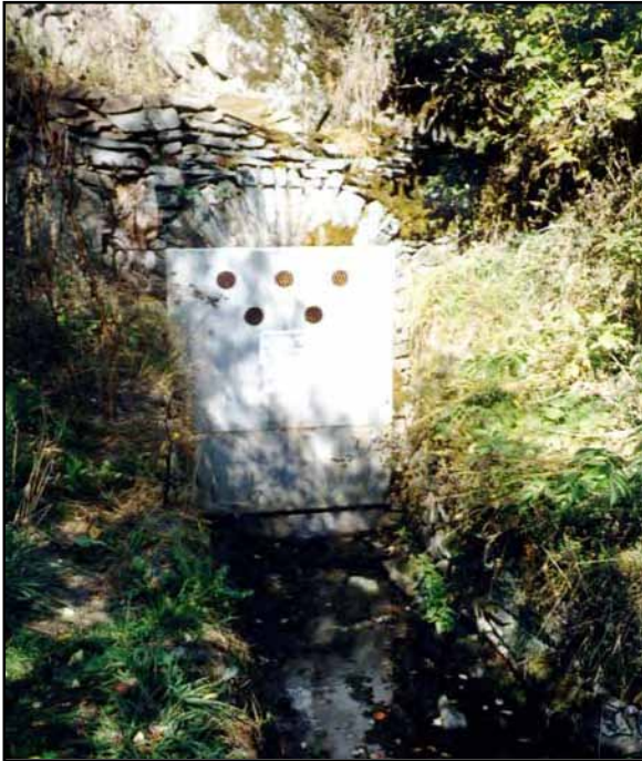
Abb. 83: Mundloch des Teichtalstollens bei Königshütte
