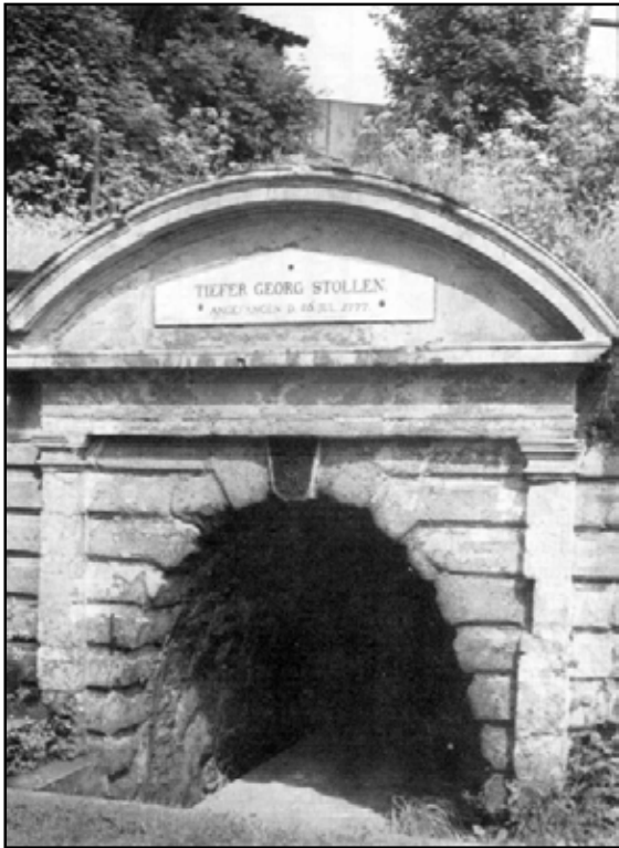
Abb.95: Mundloch des Tiefen Georg-Stollens in Bad Grund
