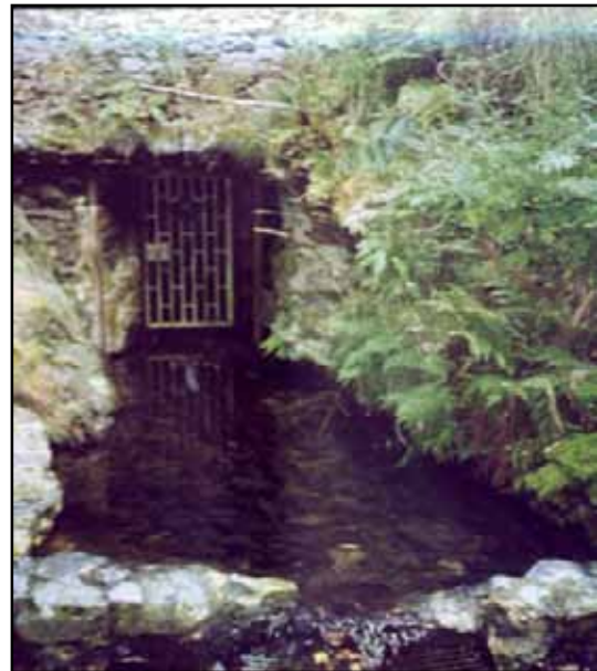
Abb.91: Mundloch des St. Annenstollens
