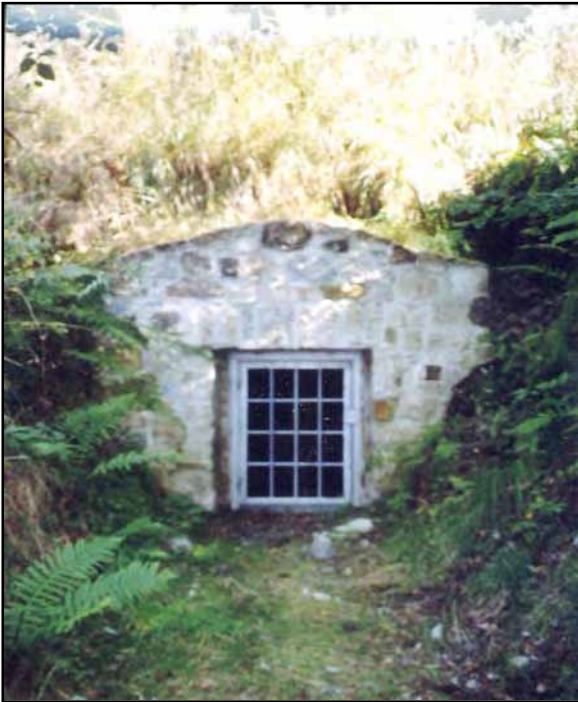
Abb. 82: Mundloch des Eierbergstollen am Hartenberg
