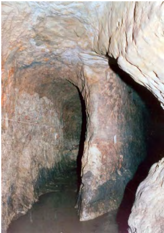
Abb. 17: Blinder Stollen im Gang I b zwischen Schacht 2 und 3, von Schacht 3 aus gesehen.
