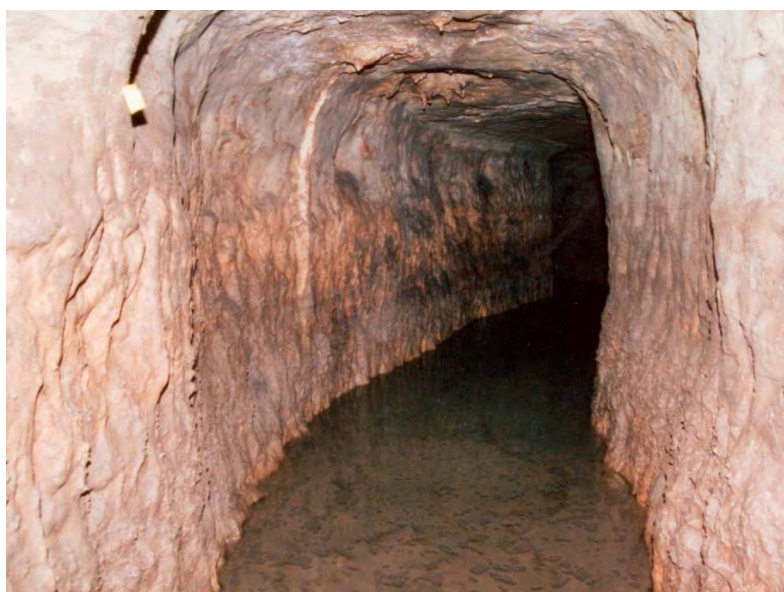
Abb. 16: Sinterbildungen an den Wänden von Gang I a, Blick nach Südosten.
